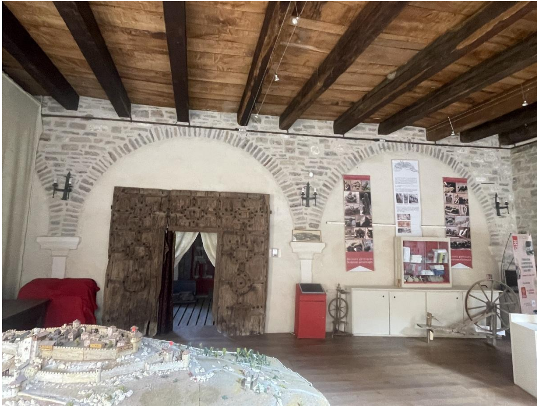
Figure 42. Parement sud du M475 restauré/rebâti, RDC. Crédit Florence Guillot.
