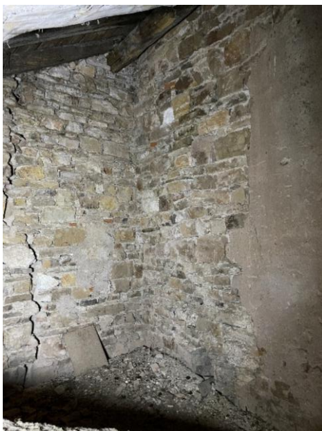
Figure 57. Chaînage M475 (à droite) et haut du M470 dans les combles.
