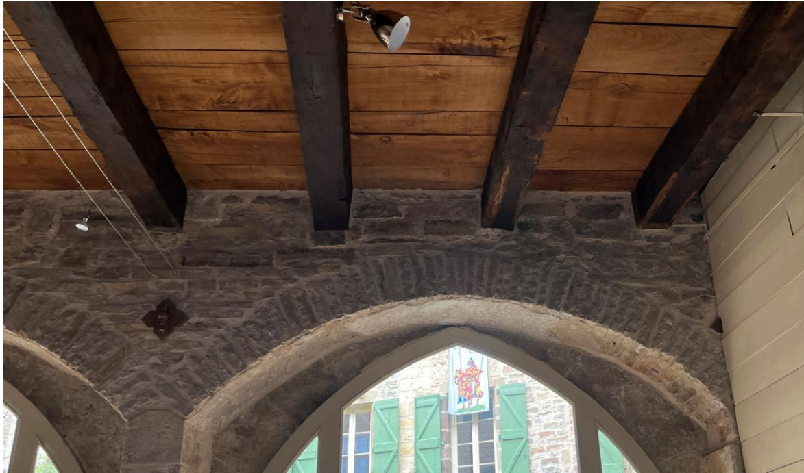
Figure 64. Poutres en place au plafond du RDC côté nord. Crédit Florence Guillot.
