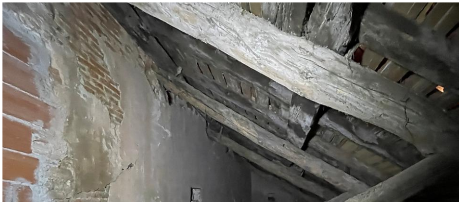
Figure 60. Mur 475 dans lequel on a ancré la nouvelle charpente. Combles. Crédit Florence Guillot.
