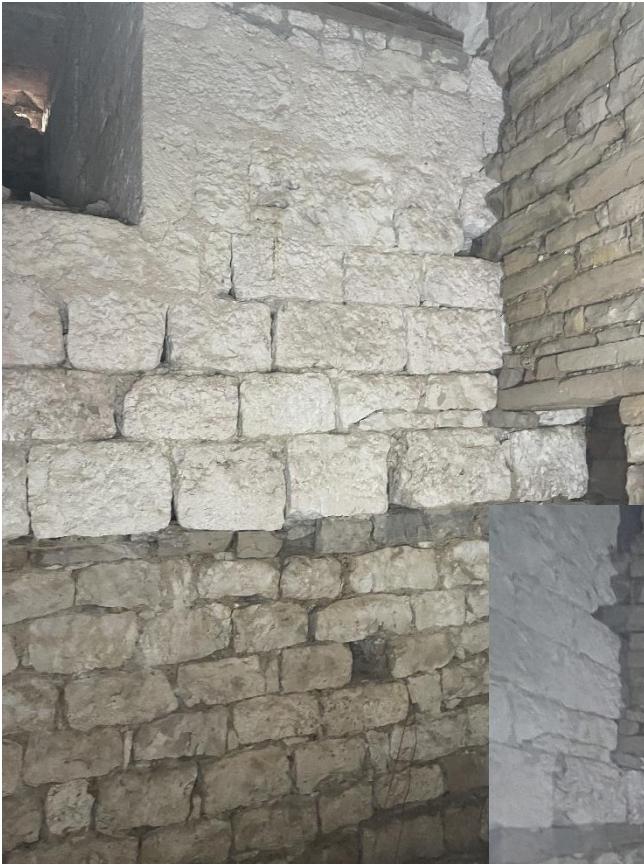
Figure 29. Sous-sol nord. M1 en Corrompis et calcaires blancs et M468 (à droite des images) ancré plus tard dans son parement interne. Crédit Florence Guillot.
