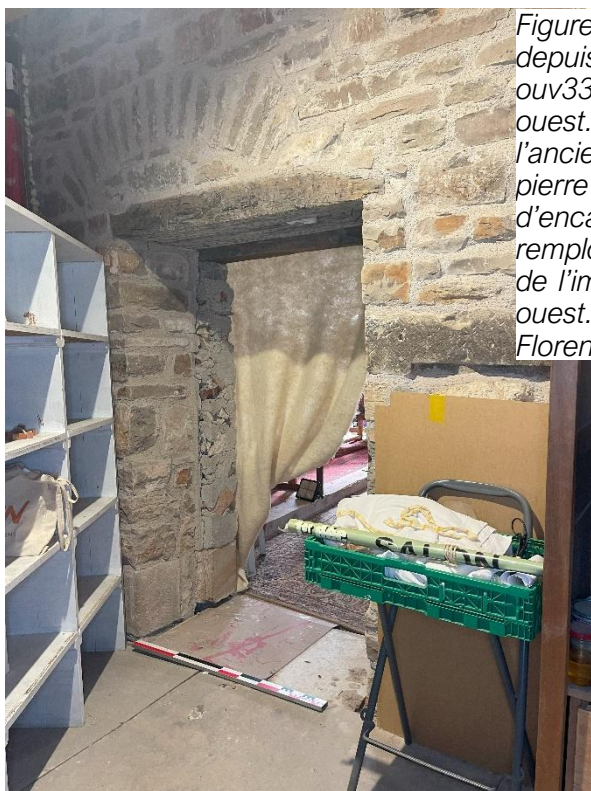
Figure 47. Insertion du M475 dans le M470 antérieur. Crédit Florence Guillot.
