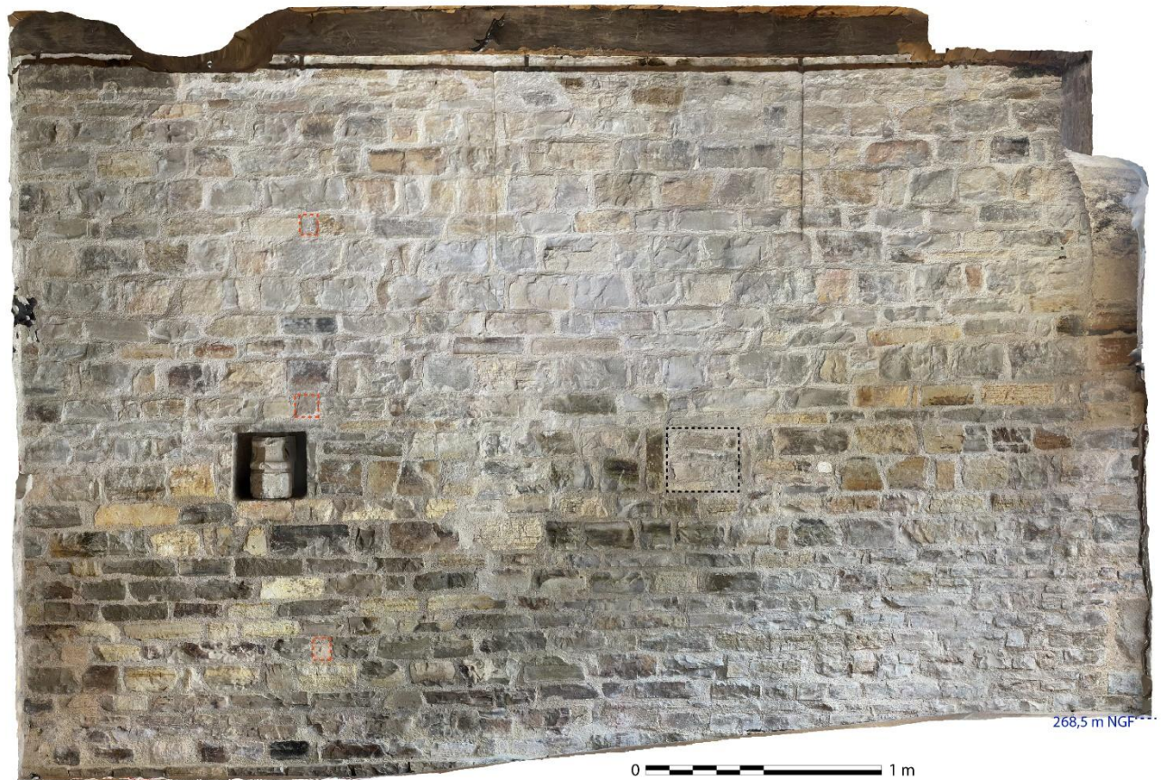
Figure 33. M468, rez-de-chaussée moitié sud (à droite arcade). Orthophotographie tirée de la photogrammétrie. Notez la niche bouchée (pointillés noirs) et la perche d'échafaudage (pointillés rouges). Crédit Florence Guillot.
