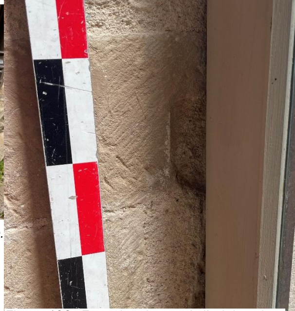
Figure 103. Encoche de gond d'origine dans un pilier d'arcade du RDC de la maison Fabre. Crédit Florence Guillot.
