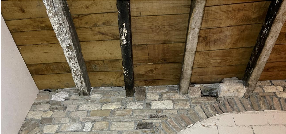
Figure 66. M475 plafond du RDC moitié sud de la maison et face sud du mur. Notez la solive de la moitié sud qui dépasse légèrement. Crédit Florence Guillot.
