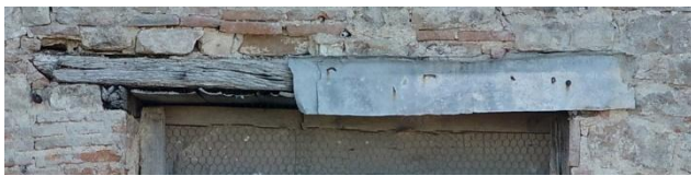
Figure 27. Linteau en bois et zinc de l'ouv11, parement externe M1. Extrait de l'orthophotographie de Pascal Robert-Cols.
