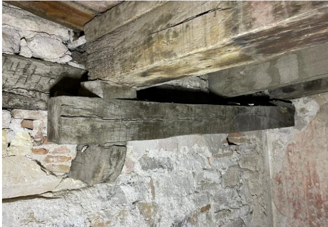
Figure 58. Angle sud-ouest, niv. +2. Poutres anciennes remployées. Crédit Florence Guillot.
