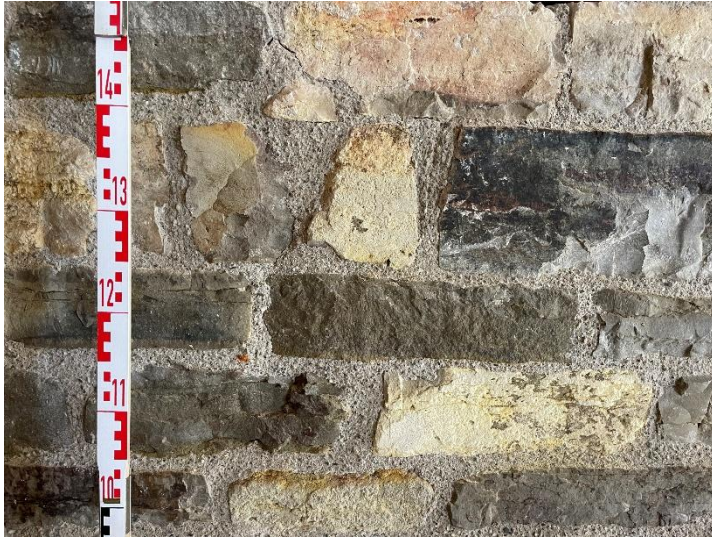
Figure 34. Calcaires blancs et Corrompis, M468. Crédit Florence Guillot.
