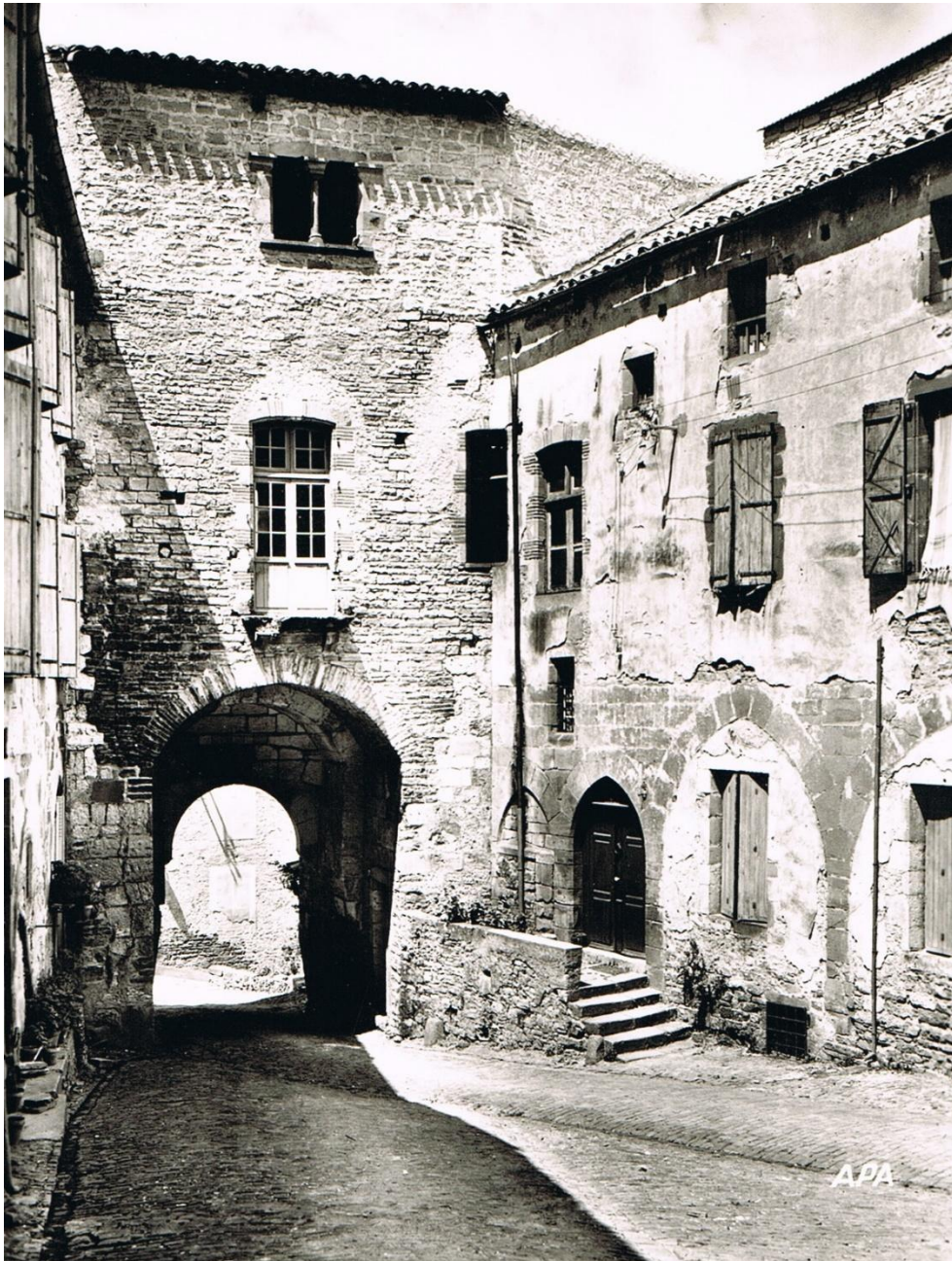
Figure 117. Façade sud de la maison Fabre et ouest de la porterie, vers 1950. Bouchage des arcades et de la petite porte. Image collection SAVC, crédit APA.
