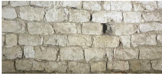
Figure 22. Calcaires jaunes mêlés à d'autres matériaux, dont des calcaires blancs (en bas). M1. Extrait de l'orthophotographie de Pascal Robert-Cols.
