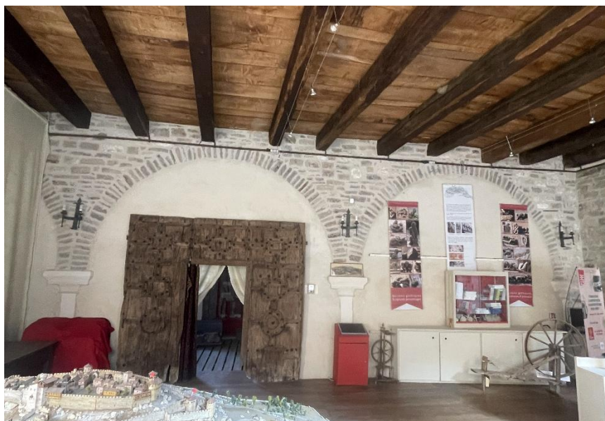
Figure 106. Mur de refend reconstruit à la fin du XXe siècle, Rez-de-chaussée de la maison Fabre. Crédit Florence Guillot.
