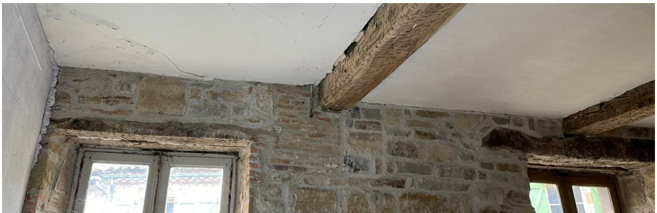
Figure 65. Plafond du niv. +1 sud. Poutre placée ou remplacée lors du changement du niveau à l'époque contemporaine. Crédit Florence Guillot.
