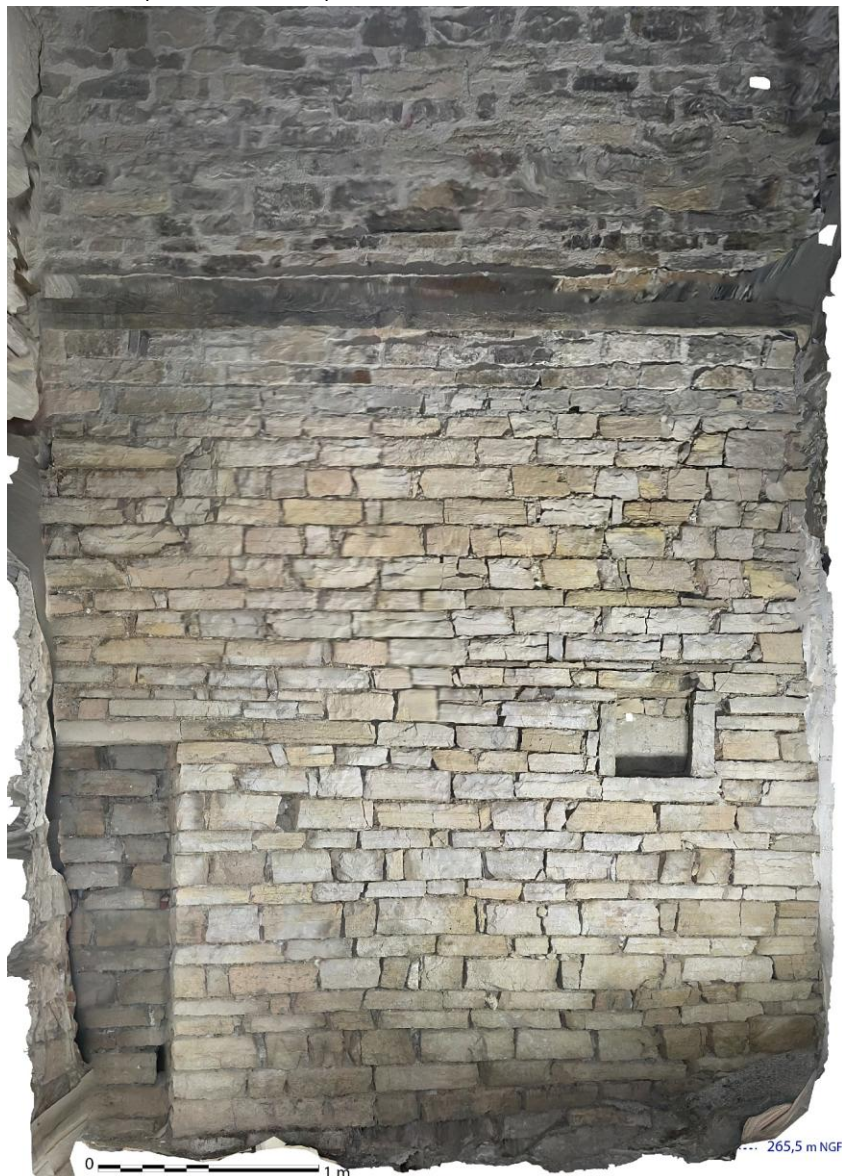
Figure 30. M468 interne côté nord, niv-1, et RDC. Orthophotographie tirée de la photogrammétrie. L'entrée bouchée se dirige vers l'actuelle maison Espiès (ouv 332). Crédit Florence Guillot.
