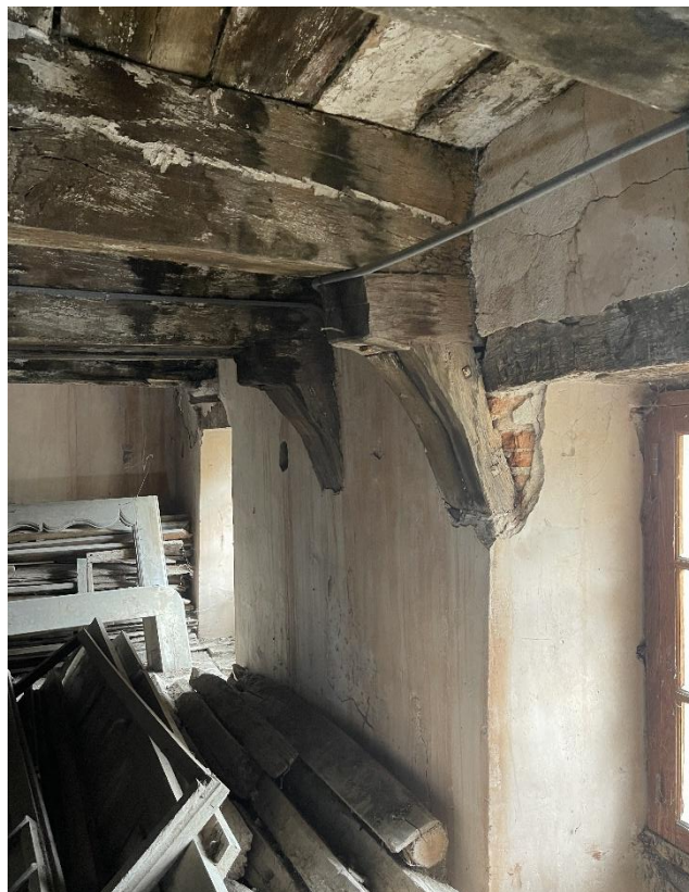
Figure 67. Niv. +2. Côté sud. Plafond. Crédit Florence Guillot.
