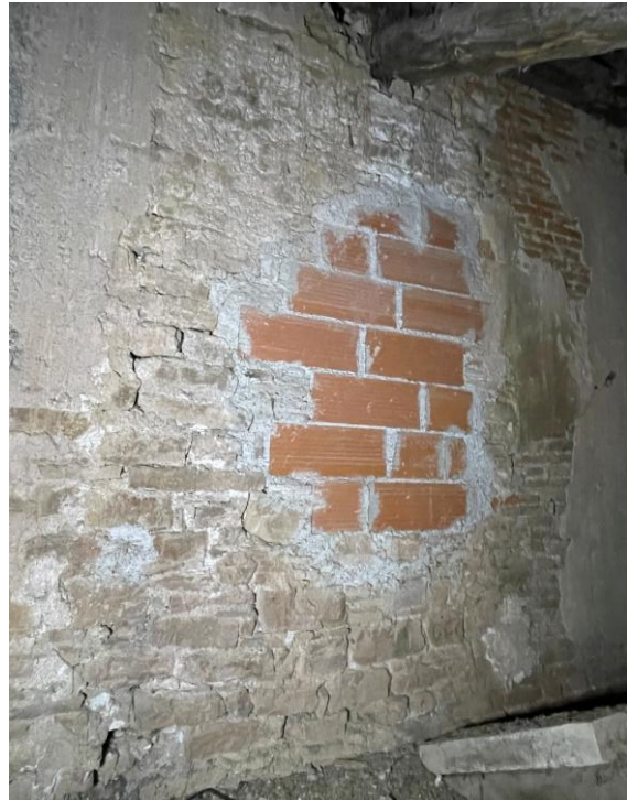
Figure 55. M475 dans les combles – face sud, réparations diverses dans le mur d'origine en Corrompis. Côté nord. Crédit Florence Guillot.
