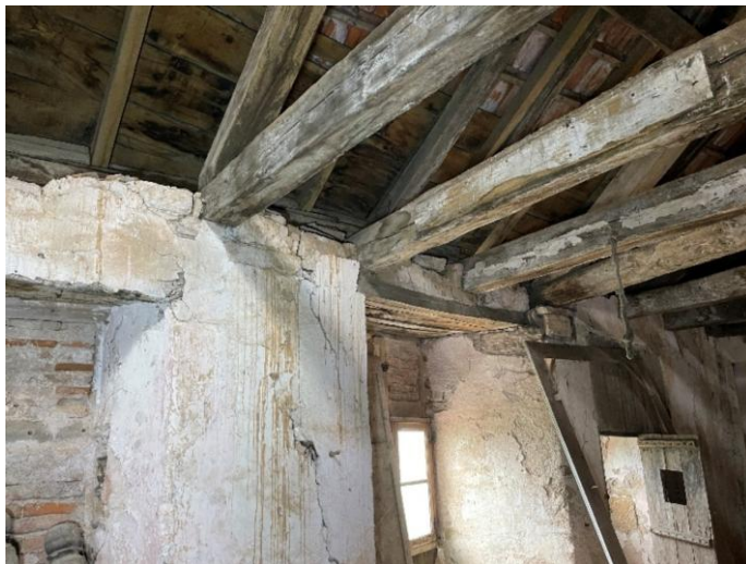
Figure 59. Niv. 2, façade nord. Charpente reposée sur le mur dérasé (M1). Crédit Florence Guillot.
