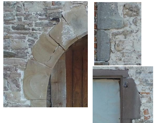
Figure 25. Exemple de grès dans les encadrements des ouvertures, parement externe M1. Extrait de l'orthophotographie de Pascal Robert-Cols.
