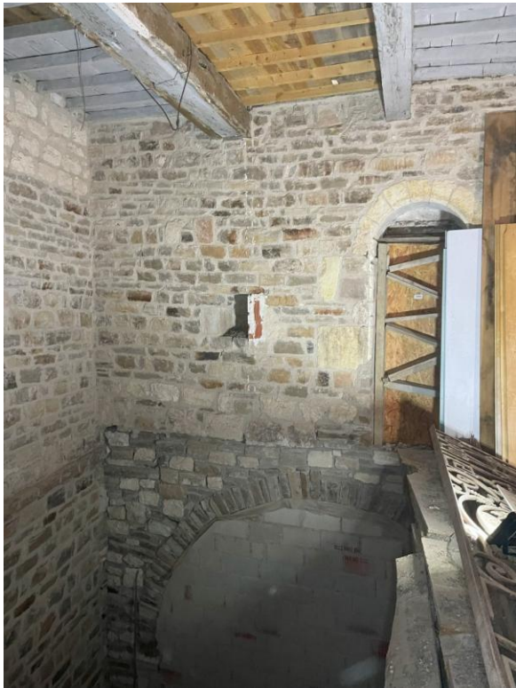
Figure 38. Niv. +1, angle sud-est M475 (refend, en face sur l'image) et M468 (latéral est maison Fabre). Notez dans l'assise en encorbellement (d'origine, à gauche de l'image) au niveau de l'étage actuel et le chaînage des deux murs, mais aussi les assises en calcaires blancs en hauteur dans le M468. Crédit Florence Guillot.
