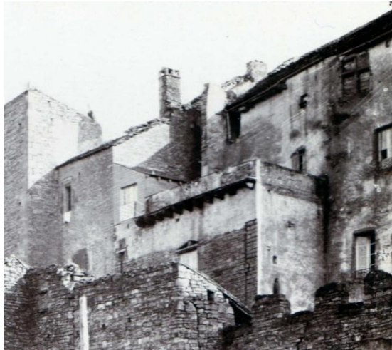
Figure 110. Nord de la maison Cordier et de la maison Fabre vers 1907. Collection SAVC.
