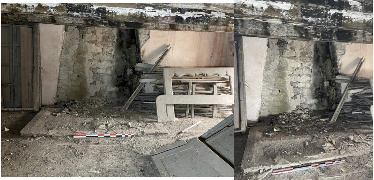
Figure 37. Cheminée au niveau 2, M468. (à gauche M465, à droite M462). Crédit Florence Guillot.
