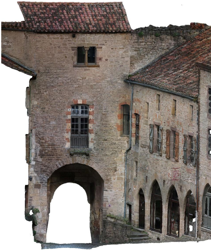
Figure 115. Façade orientale de la porterie des Ormeaux. Orthophotographie tirée de la photogrammétrie. Crédit Florence Guillot.
