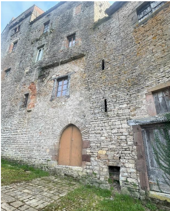
Figure 87. Possible autre tour albarrane au centre de l'enceinte nord de Cordes. Crédit Florence Guillot.
