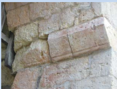
Porte de la Jane Détail de l'appui de voûte
