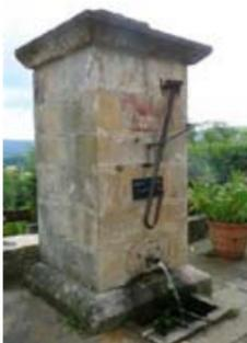
re avec pompe en fer surmonte un réservoir voûté de 16 m<sup>2</sup> sur 3 mètres de hauteur ; un couloir, large de 50 centimètres et long de 7 m, conduit cette eau à un autre réservoir voûté de 1,80 mètre de large sur 3,50 mètres de long pour une hauteur de 3 mètres. Un dernier couloir large de 50 centimètres et long de 16 mètres serpente jusqu'à la rencontre d'une roche blanche de nature molassique.
