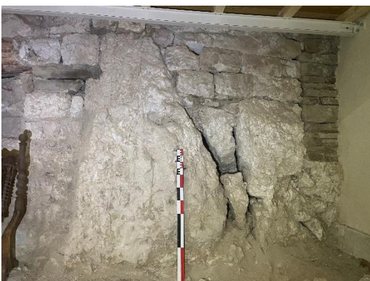
Fig. Sous-sol de la maison Fabre, côté ouest de sa parcelle, substrat retaillé et fragment de mur réutilisé pour la tour nord de la porterie et le mur ouest du niveau -1 de la maison Fabre. Crédit F. Guillot
