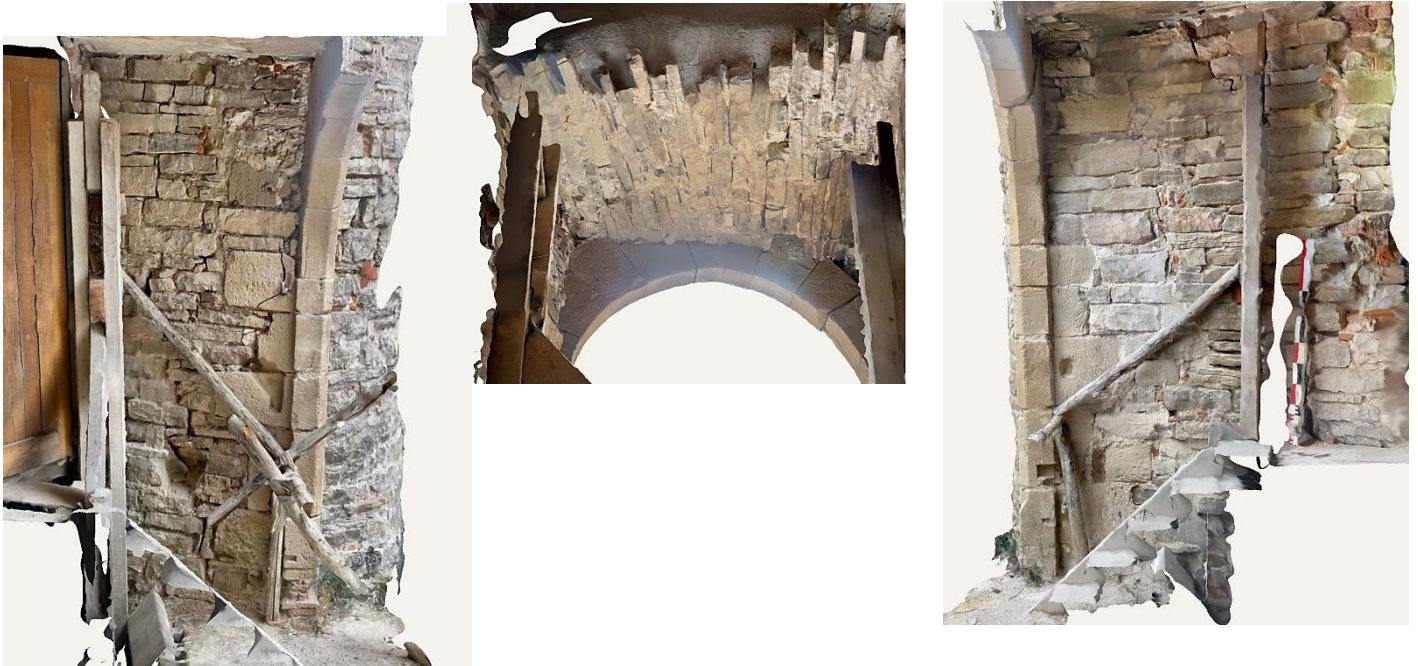
Fig. Diverses vues du couloir en arrière d'Ouv2. Extrait d'une photogrammétrie. Crédit F. Guillot
