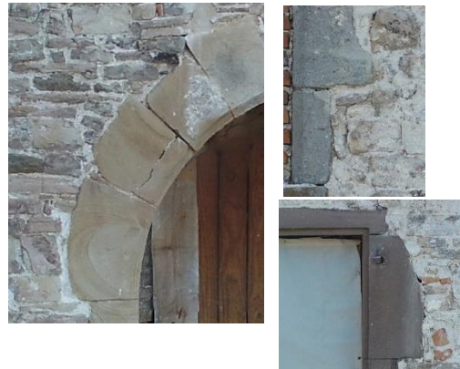
Fig. Exemple de grès dans les encadrements des ouvertures, parement externe M1. Extrait de l'orthophotographie de Pascal Robert-Cols
