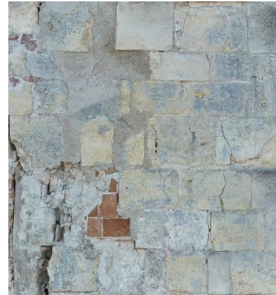
Fig. Calcaires jaune mêlés à d'autres matériaux, dont des calcaires blancs (en bas). Contact tour nord de la porterie (à droite) et M1. Extrait de l'orthophotographie de Pascal Robert-Cols
