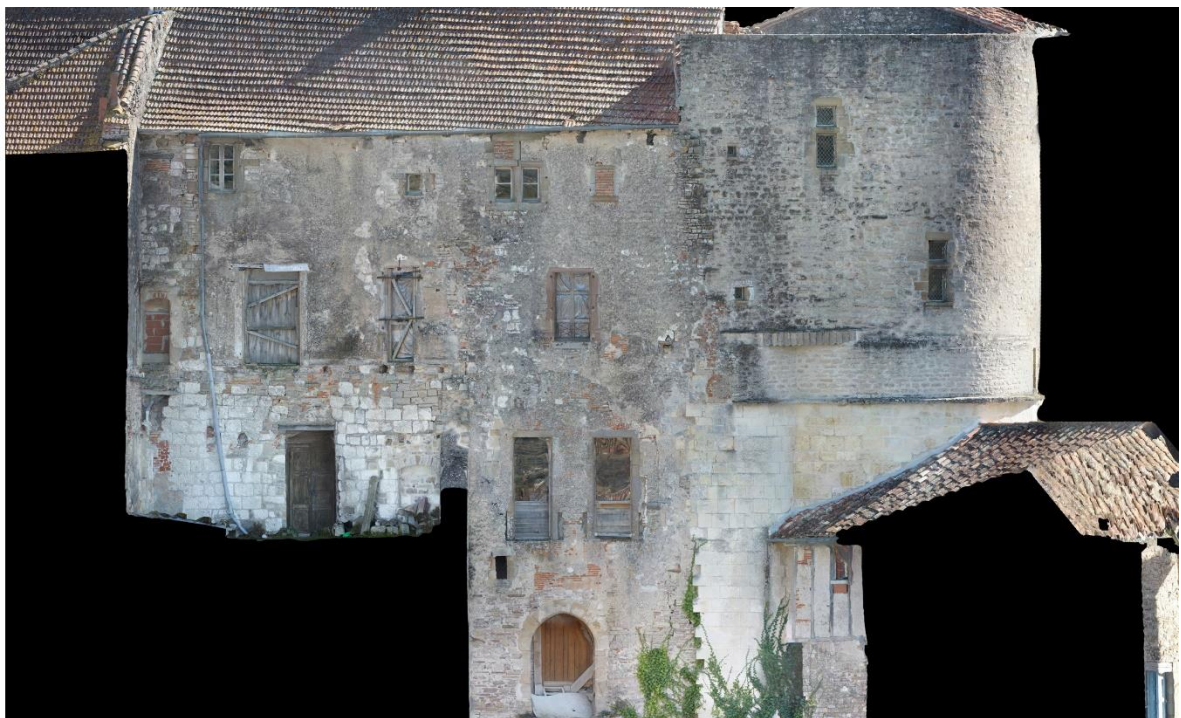
96. Orthophoto : Façade Nord avant piquage
