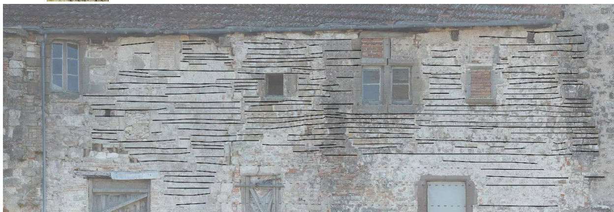
Fig. Concordance ou discordances des assises des unités de bâtis anciennes du haut de la façade. Extrait de l'orthophotographie de Pascal-Robert-Cols
