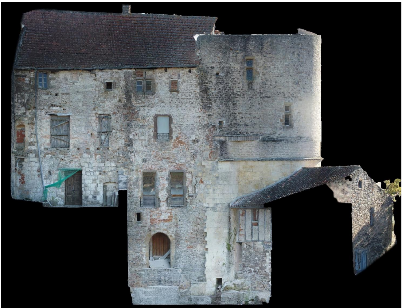
Fig. Façade nord de la maison Fabre sans le bâtiment accolé et après piquetage. Orthomosaique de la photogrammétrie. Crédit Pascal Robert-Cols
