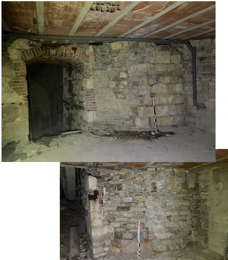
Fig. Partie basse du feston central — entre ouv3 et M54 (à l'arrière des restes de la maison accolée). Uc6, 5, 130,126, 113 et 7. Notez (image du bas), les empochements maçonnés de poutres qui ont été bouchés. Elles correspondent à un retrait pour plancher du M4 et à un aménagement contre M131 partie basse. Crédit F. Guillot.
