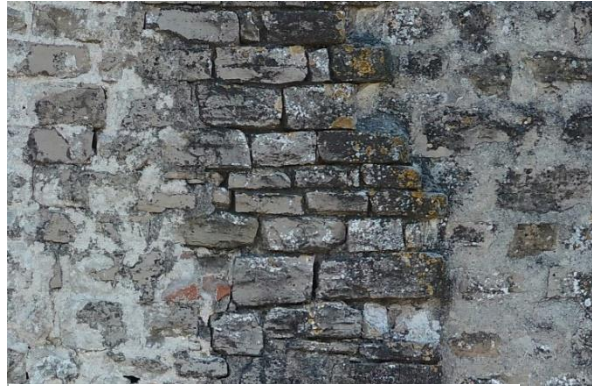
Fig. Calcaires dolomitiques. Contact tour nord de la porterie (à droite) et M1. Extrait de l'orthophotographie de Pascal Robert-Cols
