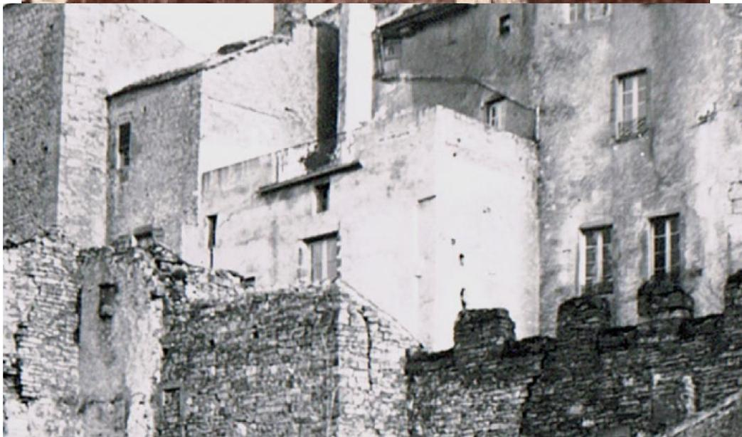
*Fig. Fin XIXe siècle – début XXe siècle : l'ancien toit-terrasse en place. Notez la différence entre les deux images (présence ou pas d'ouvertures de jour rectangulaires juste sous le toit-terrasse). Notez aussi que sur l'image la plus ancienne, l'enduit est en bon état, peut-être peu ancien et donc repris lors de la création du toit-terrasse au cours du XIXe siècle.
