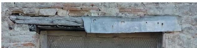
*Fig. Linteau en bois et zinc de l'Ouv11, parement externe M1.
