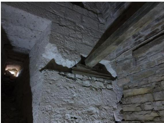
Fig. Angle nord-est de la maison Fabre. Empochements creusés (façonnés) dans le M1 au niveau de l'ouv233 qui devait déjà être bouchée quand ce niveau (=actuel niveau du RDC à l'est) était en service. Crédit F. Guillot
