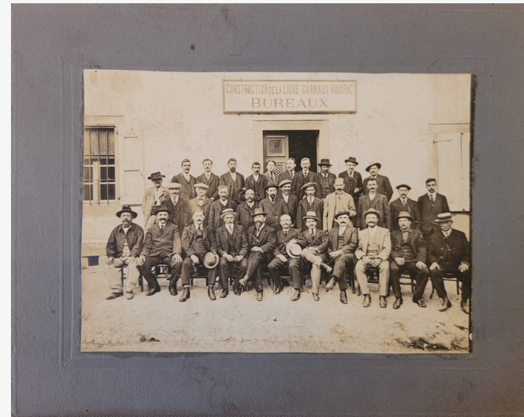
Personnel administratif lié à la construction de la ligne Carmaux - Vindrac (prêt de Yves Calmels).
